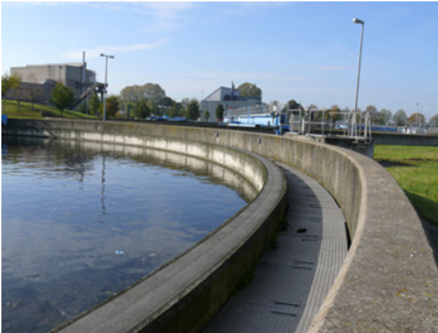
Bild 10: Nachklärbecken 8 nach 10-jährigem Betrieb
