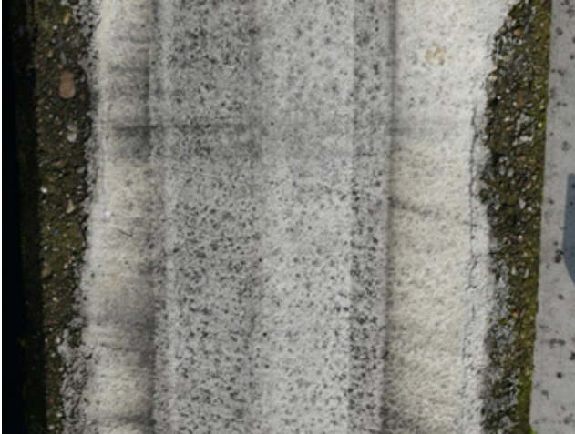
Bild 13: Instandsetzung mit einem Edelstahlfasermörtel
