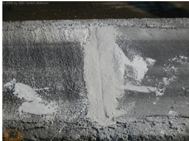
Bild 14: Reparatur einer Hohlstelle
