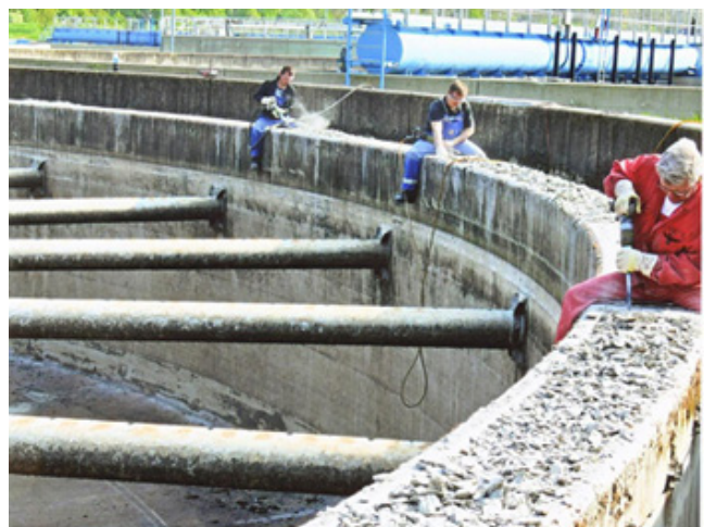
Bild 12: Betonabtrag
