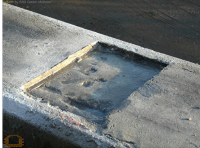
Bild 14: Reparatur einer Hohlstelle
