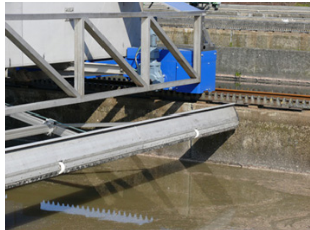
Bild 1: Nachträglicher Einbau eines Stahl-Fachwerkträgers zur Aussteifung
