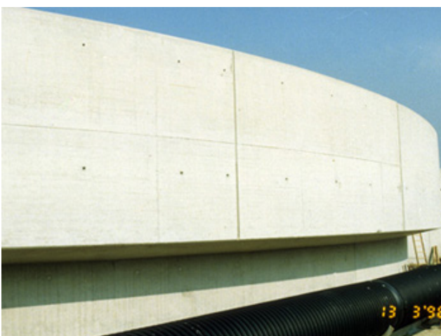
Bild 5: Sichtbeton eines Nachklärbeckens: Neubauzustand
