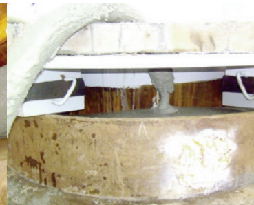
Verguss des Ringspaltes (grouted joint) mit PAGEL V1/60 HF Hochfestverguss
