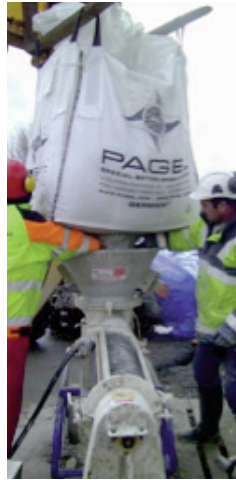
Befüllung der PABEC Misch- und Förderpumpe
