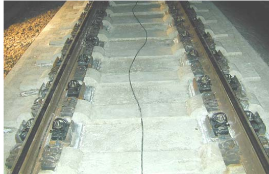
Abb. 14 : Ansicht des Umgebauten Gleisbereichs im Netzbezirk Wustermark
