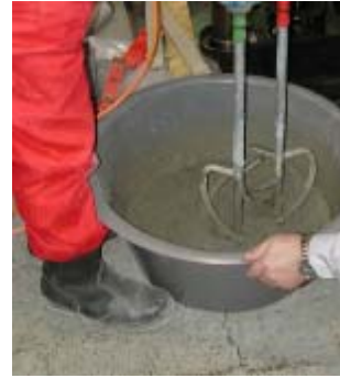
Abb. 7 u. 8: Hochleistungsmörtel V2/40 (Fa. Pagel) Gebinde bei Anlieferung und Anrühren mit Wasser
